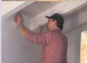
↑ Der Einsatz neuentwickelter Techniken schafft ein gesundes Raumklima.
