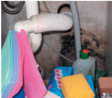
Schimmelschäden sind heute häufige Ursachen für eine Schadstoffbelastung der Innenraumluft. Meist entstehen sie dort, wo sich an so genannten Wärmebrücken Kondenswasser bildet und das Wachstum von Schimmelpilzkulturen beschleunigt.
